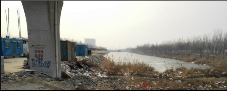
图 1-8-4 西大洼排水河照片
