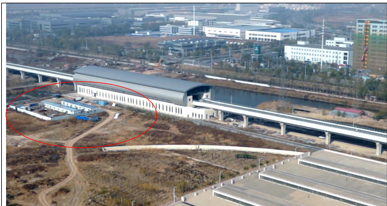
学府工业区东侧临时生产、生活设施照片
