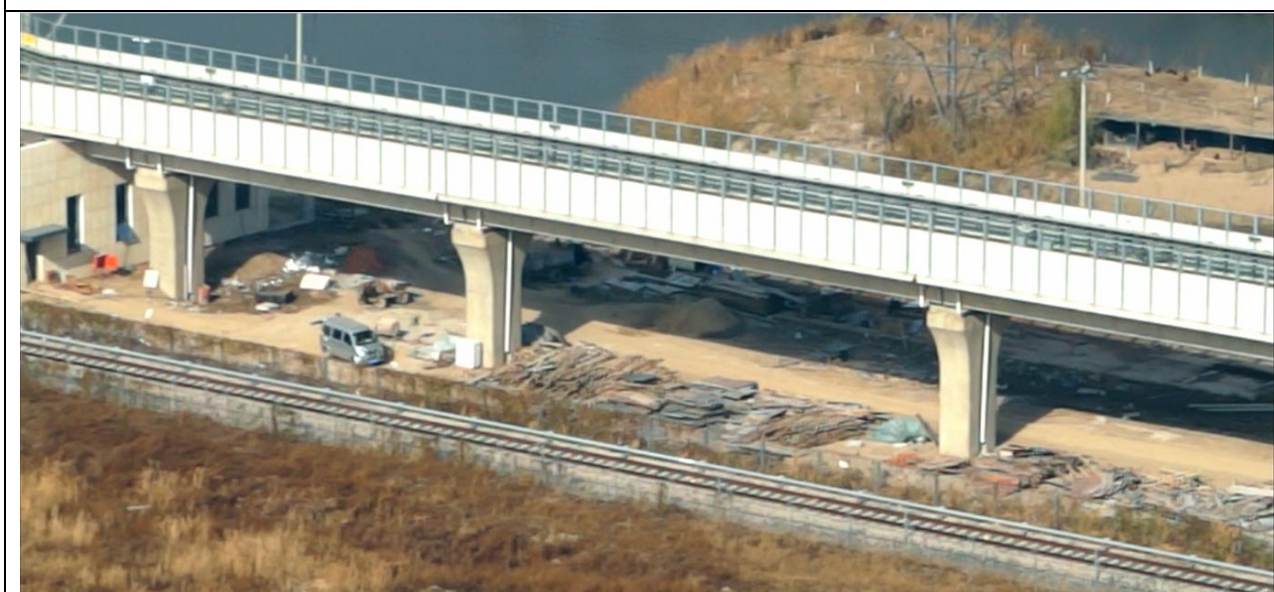
区间征地红线与桥梁之间材料临时堆放地照片
