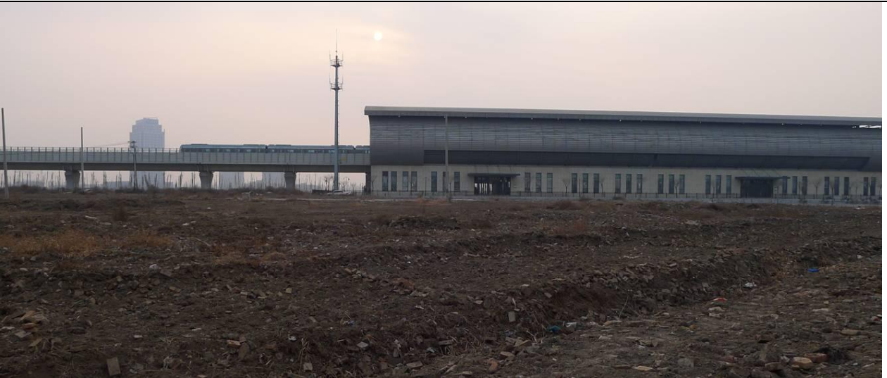
杨伍庄村平房住宅拆迁场地照片
