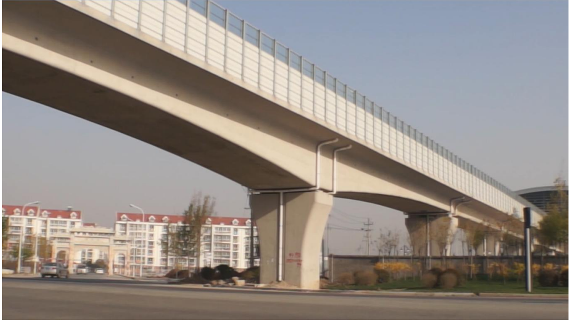
跨赛达大道桥梁照片
