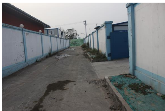
施工生产生活区
