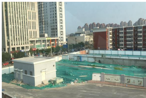
施工生产生活区密目网苫盖
