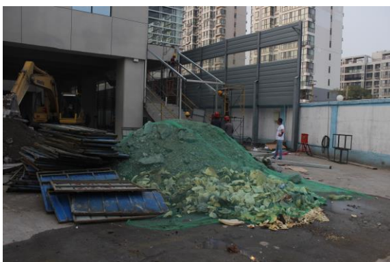
临时堆土苫盖
