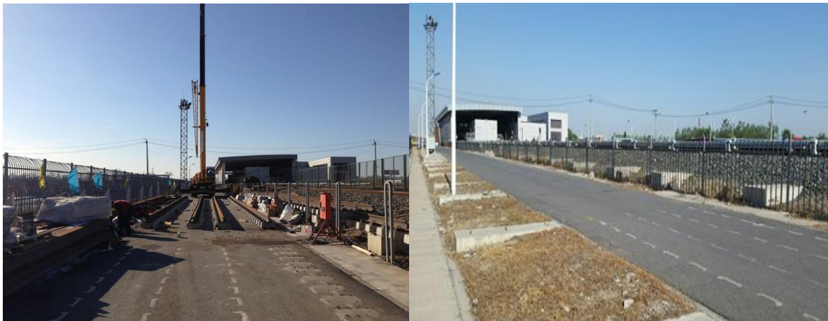
铺轨基地施工中
