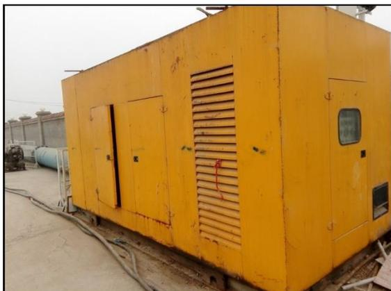
芥园西道站施工现场将空压机在内设隔音板的临时房间
